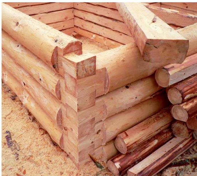
Составом "БИОСЕПТ" следует обрабатывать поверхности сруба не подверженные прямому действию воды
